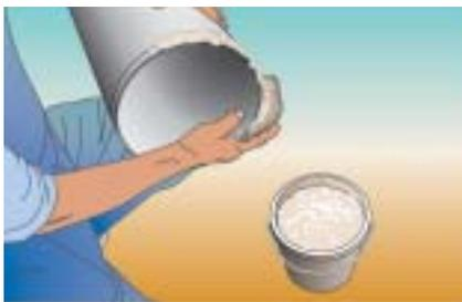
Lubrifier l'embout mâle sur toute la circonférence, principalement le chanfrein. Pour les gros diamètres il est parfois nécessaire de lubrifier également la partie apparente du joint, dans ce cas ne jamais mettre de pâte dans la gorge.
