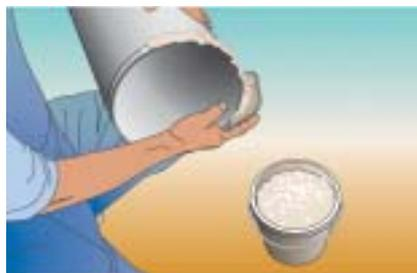
Emboîter les éléments à fond par poussée longitudinale, soit à la main...
