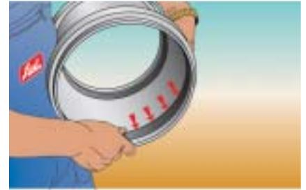
Contrôler le bon positionnement du joint dans son logement.
